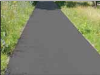
Nieuwe toplaag fietspad
